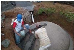
Pembuatan reaktor biogas kotoran ternak sapi.
